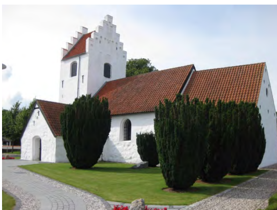
Halling Kirke, Spøttrupvej 8
