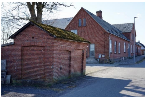
3. Sprøjtehuset i Tvenstrup – ikke omfattet af kulturmiljø og skal derfor SAVE vurderes
